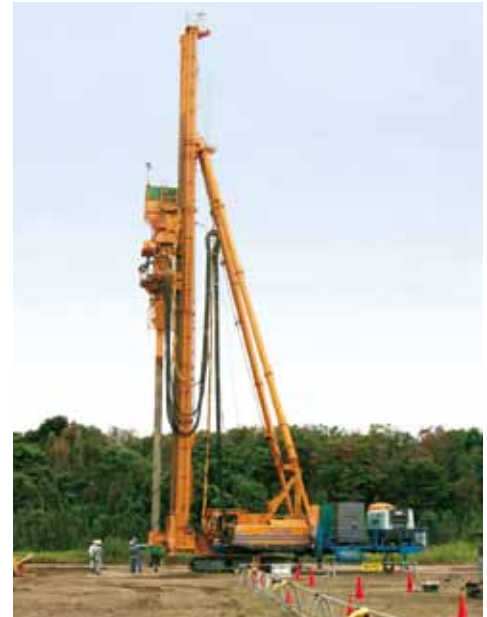
陸上用SCP施工重機
